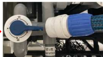
水道ホースを接続します
