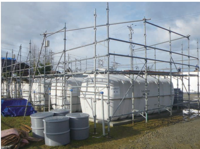
能登半島地震 仮設浄化槽の設置
