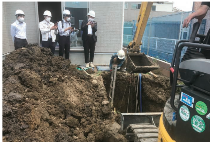
環境省担当者を浄化槽施工現場へご案内
