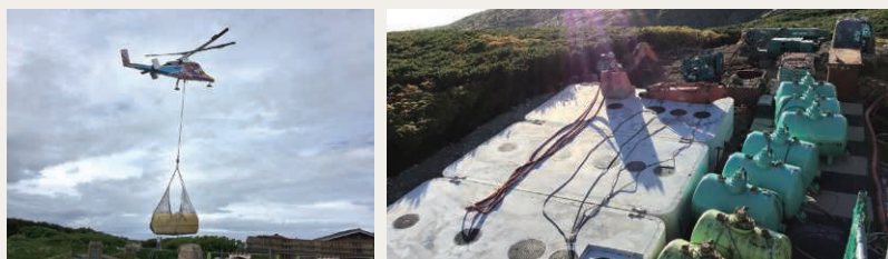
白山室堂の公衆トイレ大型浄化槽設備工事の様子
