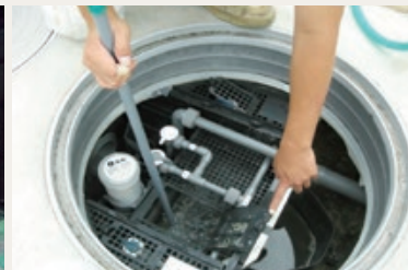
浄化槽保守点検作業
